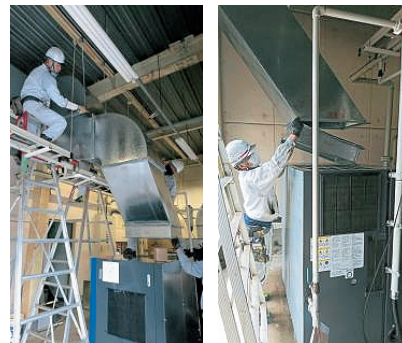
温度上昇対策、排気ダクト取付工事
