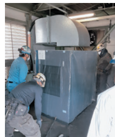
コンプレッサ設置、配管工事
