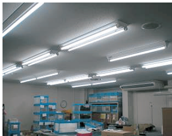
照明LED化の改修工事
