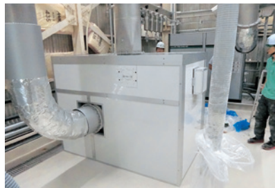
施工後ポンプ
