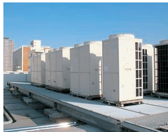
室外機「撤去・設置」ビル空調改修工事
